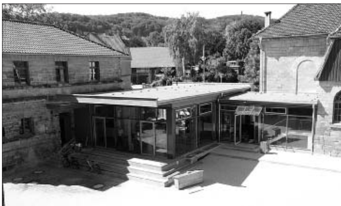
Der Speiseraum im Erdgeschoss ist durch eine Glasfassade zum Schulhof geöffnet.
