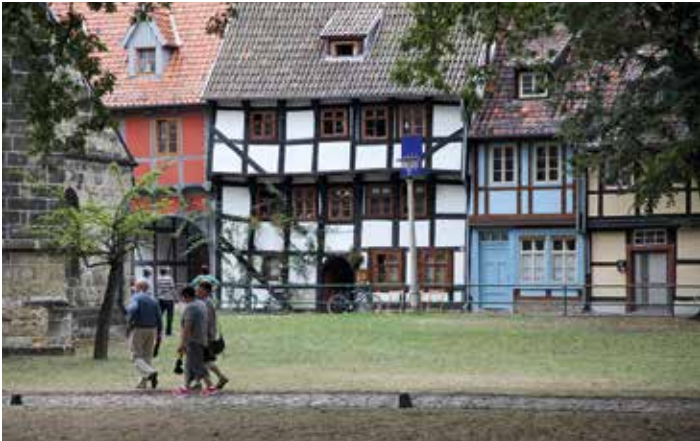
Der Neustädter Kirchhof in Quedlinburg bietet eine bunte Ansicht an Fachwerkbauten, die bereits saniert wurden.
