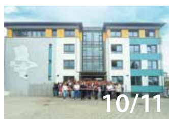
Bodfeld-Schule ist saniert
