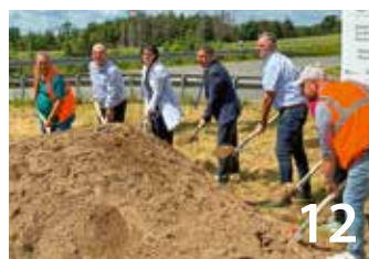
Spatenstich für Straßensanierung
