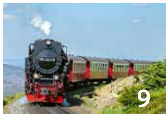
Sanierung der Brockenbahnstrecke kann starten
