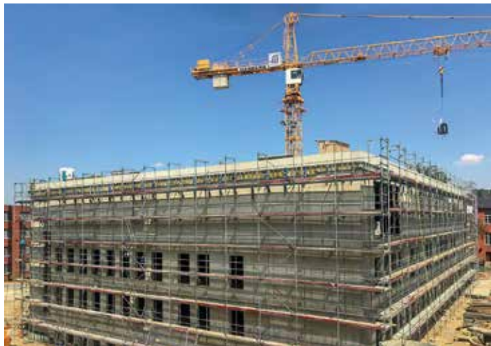
Rohbau des neuen Klinikgebäudes für das Harzklinikum Dorothea Christiane Erxleben in Wernigerode
